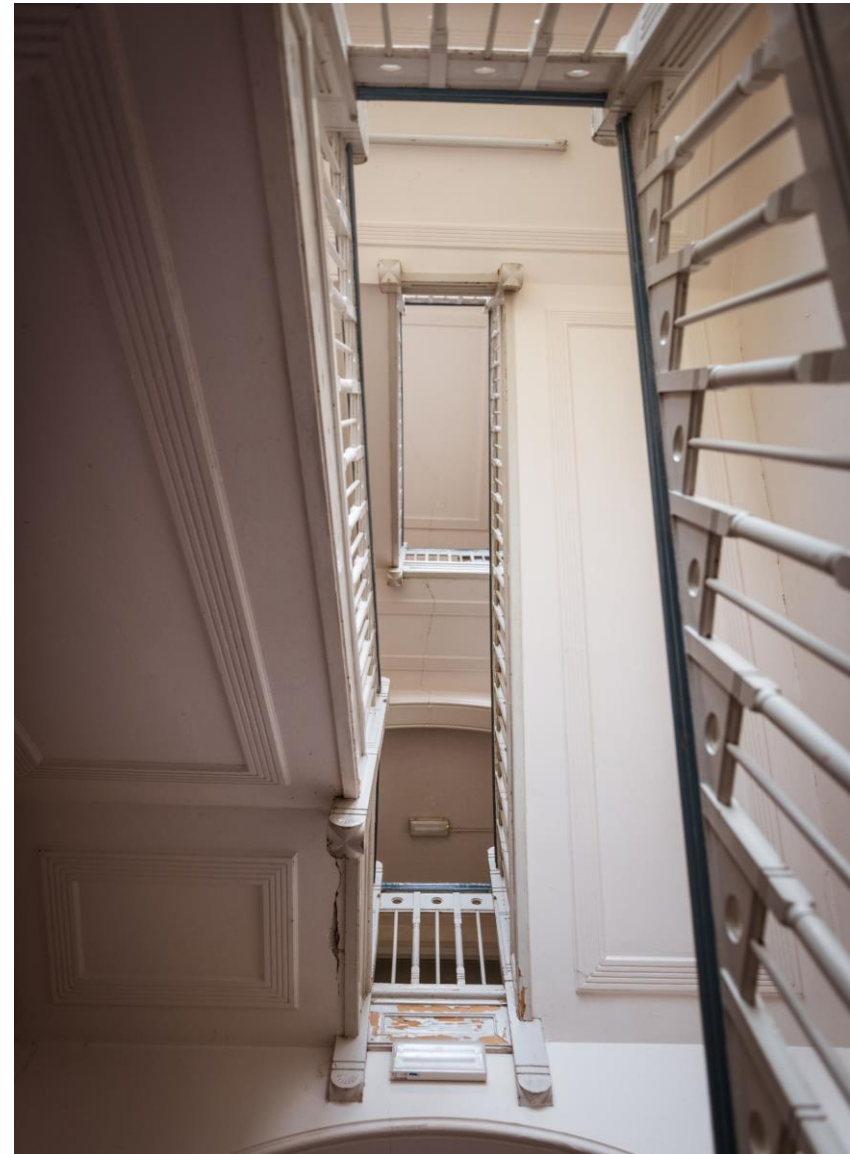
Trappenhuis van permanent atelierpand aan de Dobbelsmannweg in Nijmegen
